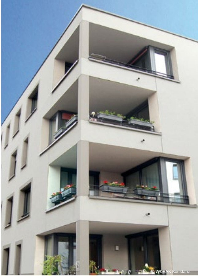
Balkone an der Bruder-Klaus-Straße
